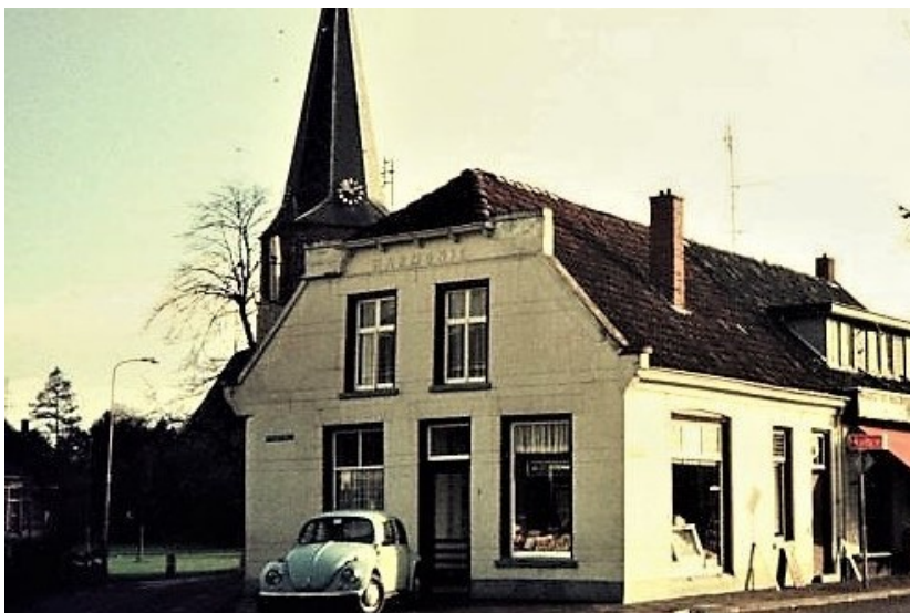
De Harmonie in de jaren '70, met gepleisterde muren en rechte gevel.
