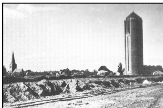
Het depot voor munitie en brandstof bevond zich links van de watertoren aan de rondweg
