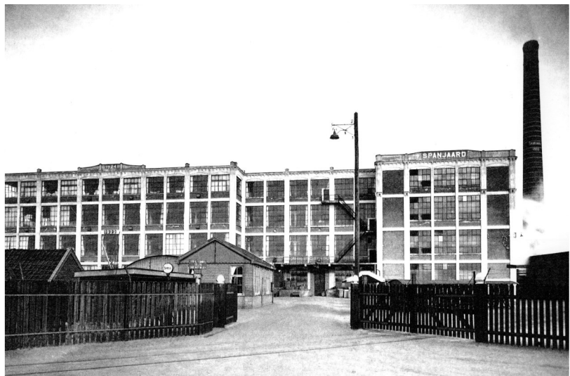
De ingang van de fabriek van Spanjaard aan de parallelweg
