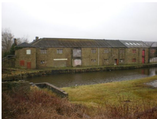
Enfield Wharfs in Clayton le Moors (Engeland) gelegen aan het kanaal Leeds-Liverpool. Het leisteren dak, dat tijdens het gebruik van 'de Wharf' door Spanjaard's Mill gedeeltelijk afbrandde, werd vervangen door een dak van asbestplaten. Het is aan het eind van het gebouw nog juist te zien.
