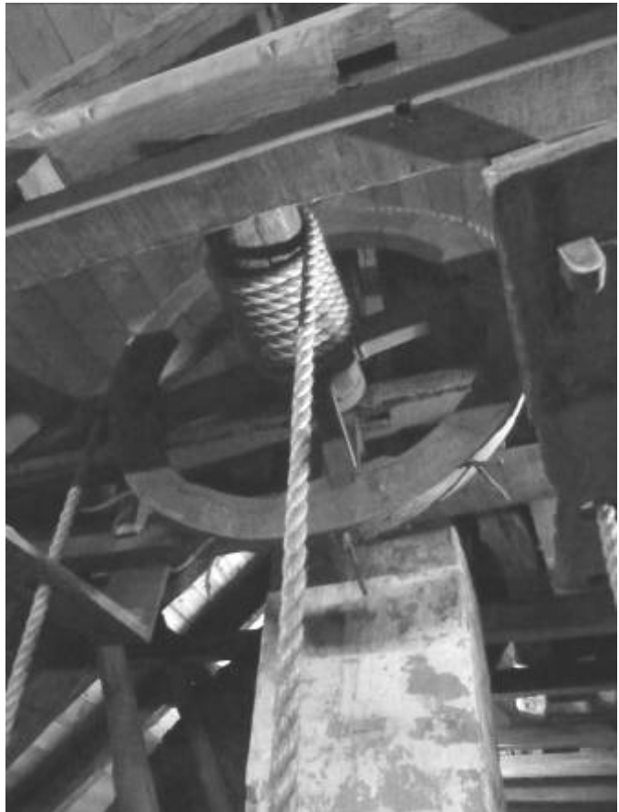
Het luiwerk van eind 19 e eeuw. Met het hijsstelsel werden de goederen vanuit de gang voor opslag naar de zolder getakeld.
