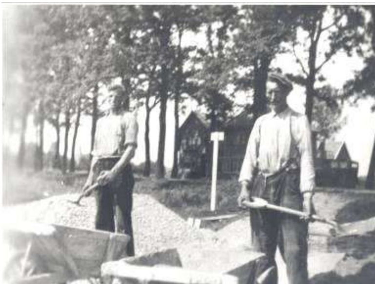
De heren Drenth en Westerbeek bezig met de graafwerkzaamheden ten behoeve van de Theresiakerk
