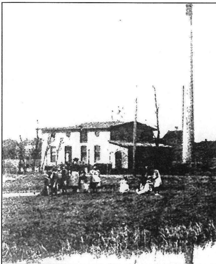
De oude Electriciteitscentrale.
