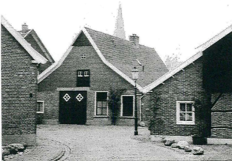
Het pand van Linthorst aan de Ennekerdijk.
