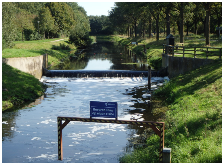
Een balgstuw in de Bornse Beek bij de Stroom Esch. (Foto: auteur van dit artikel)
