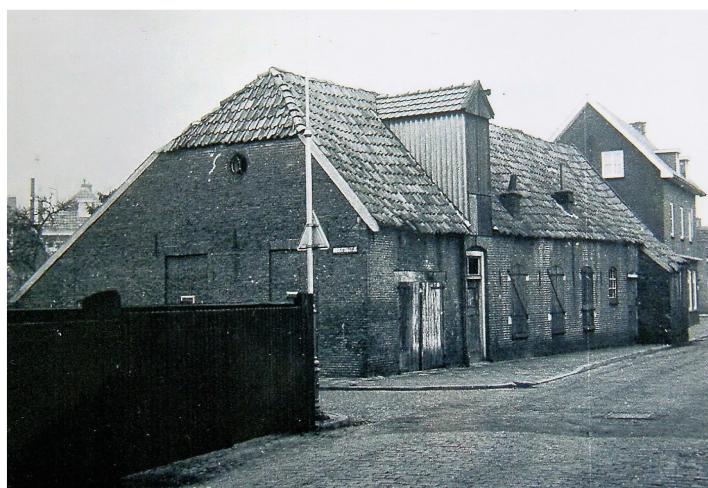
Twee keer de cichoreifabriek 'Tusveld'. Aanvankelijk zonder, later mét de dakkapel met hijsinrichting. Aan de dichtgemetselde vensterpartijen is duidelijk te zien dat het oorspronkelijk een woonhuis is geweest.
