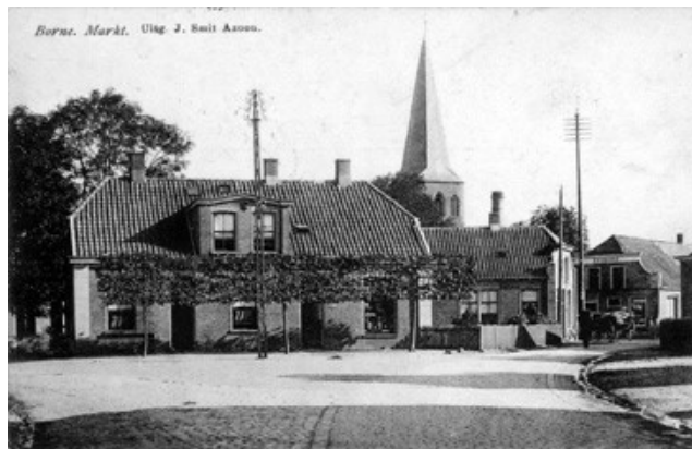
In de dubbele woning op de voorgrond woont links de familie Nieuwenhuis en rechts Blomberg. De woning is afgebroken begin jaren '50 in verband met de reconstructie van de Grotestraat / Dorsetplein.
