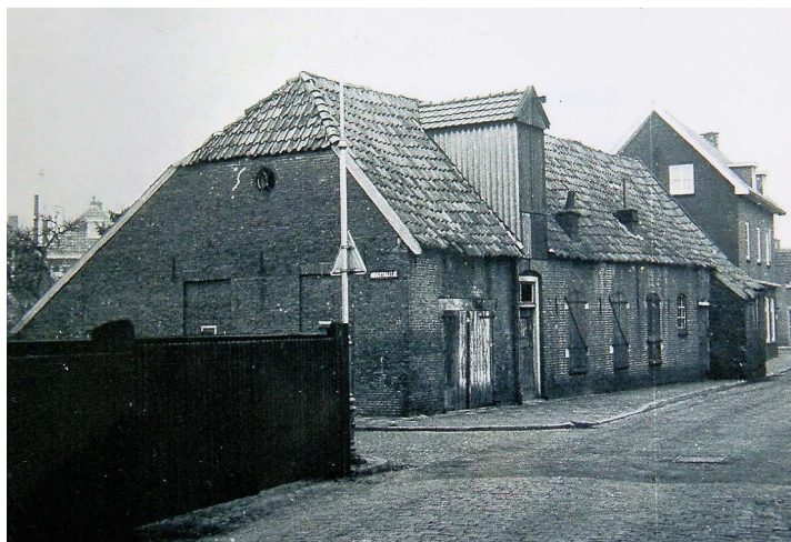
Twee keer de cichoreifabriek 'Tusveld'. Aanvankelijk zonder, later mét de dakkapel met hijsinrichting. Aan de dichtgemetselde vensterpartijen is duidelijk te zien dat het oorspronkelijk een woonhuis is geweest.
