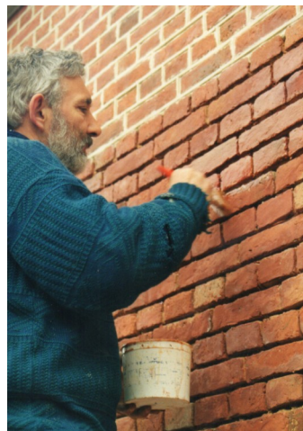
Joop Kroeze brengt de gevel steen voor steen op kleur.
