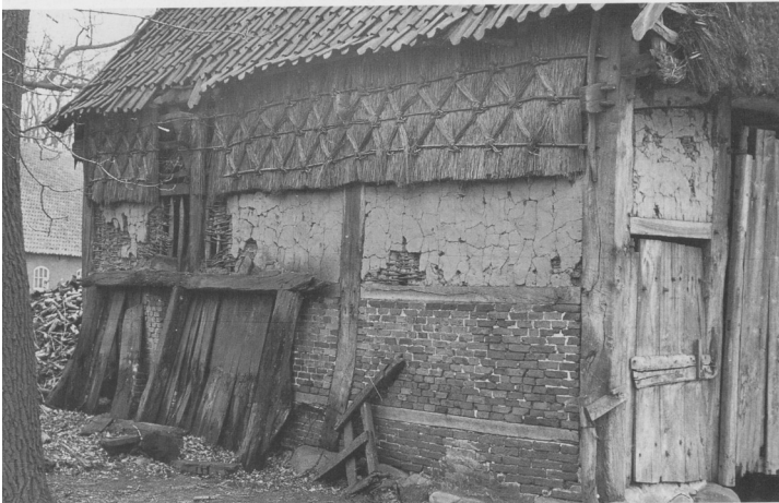
Zijwand van een schaapskooi in Hezingen. Van onder naar boven: vakwerk met baksteen op veldkeienvoet, vakwerk met leemvulling en strovlechtwerk.
