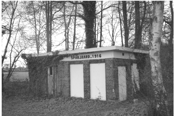
Het pompgebouw van Spanjaard, gefotografeerd in 2010 aan de Piepersveldweg. (foto: Jan Deckwitz)
