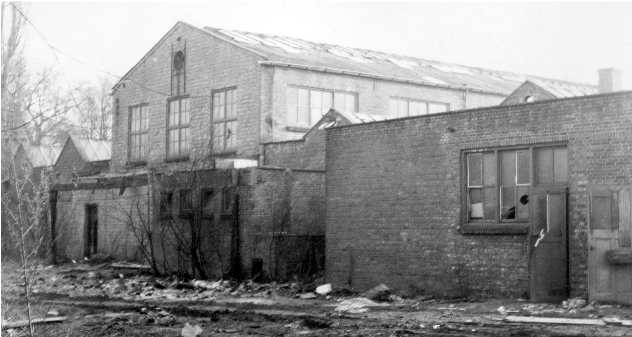
De fabriek in verval rond 1970. De panden zijn gesloopt om plaats te maken voor de woningen aan de Nieuwe Es.
