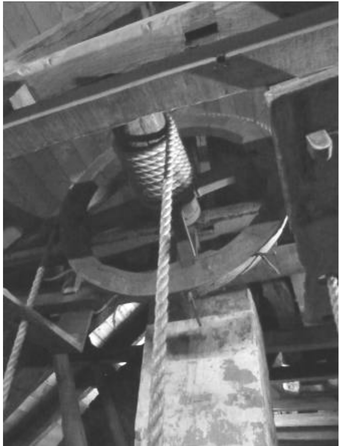
Het luiwerk van eind 19 e eeuw. Met het hijsstelsel werden de goederen vanuit de gang voor opslag naar de zolder getakeld.
