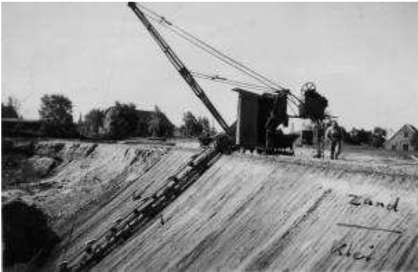
Bagger in bedrijf. De pijlen geven aan hoe de transportband met de kleibakken naar beneden en naar boven gaat.
