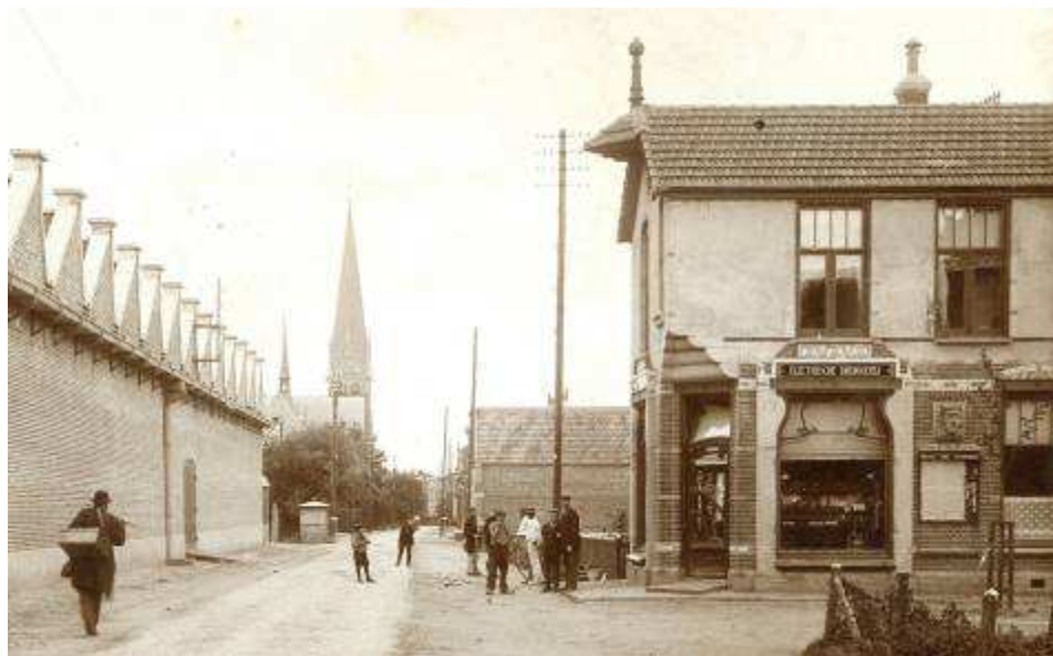
Het woonhuis annex drukkerij van J.C. Heise op de hoek van de Stationsstraat en Cuba. De gevelsteen boven een mededelingenbord is duidelijk in de zijgevel aangebracht.
