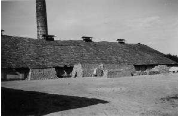
Ringoven van buiten gezien. Op de voorgrond het tasveld met gebakken stenen.
