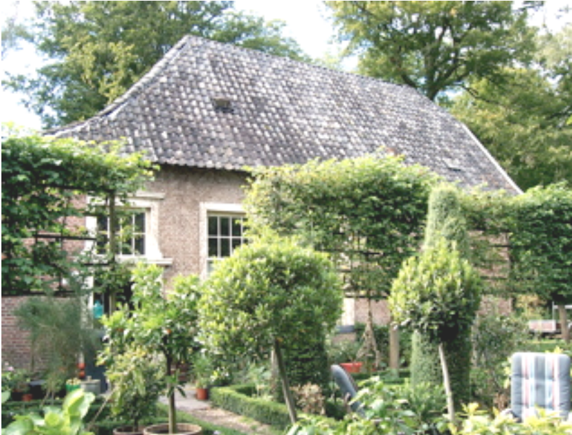
Het fraai gelegen meesterhuis ziet er ogenschijnlijk goed uit, een grondige restauratie is echter noodzakelijk
