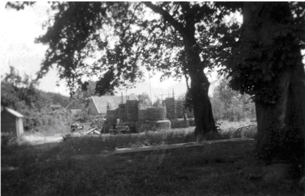
De kapel in aanbouw. Rechts de oude beukenboom
