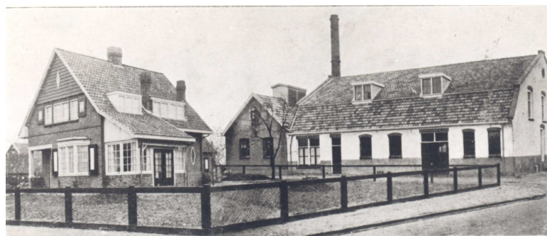
Melkfabriek aan de Ennekerdijk
