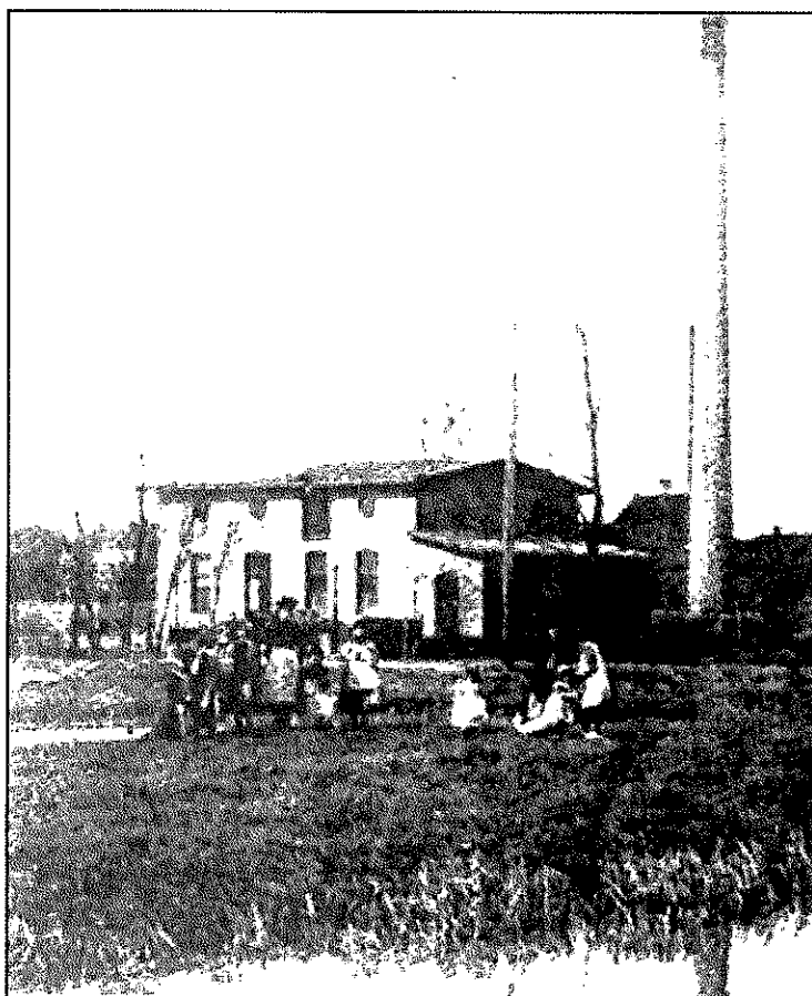
De oude Electriciteitscentrale.
