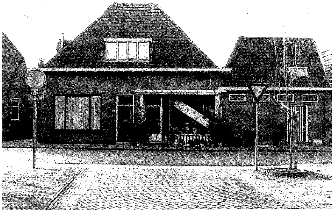
Het huidige pand Grotestraat 139 - 141 waarin de slagerij van Kuijper gevestigd was.
