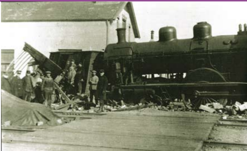
Plaatje 110. In de nacht van 30 oktober 1920 ontspoord er bij de spoorwegovergang in de Azelosestraat een goederentrein. Er is één dode gevallen en er zijn twee gewonden. Het gebouw op de achtergrond is van de Boerenbond. Nu is hier het nieuwe kantoor van een architectenbureau.
