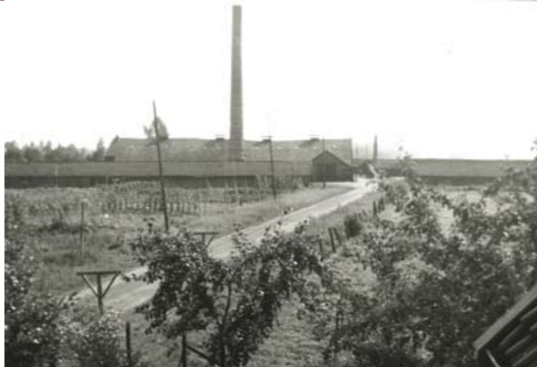
Plaatje 106. De steenfabriek van Morselt aan de Oude Deldenseweg.
