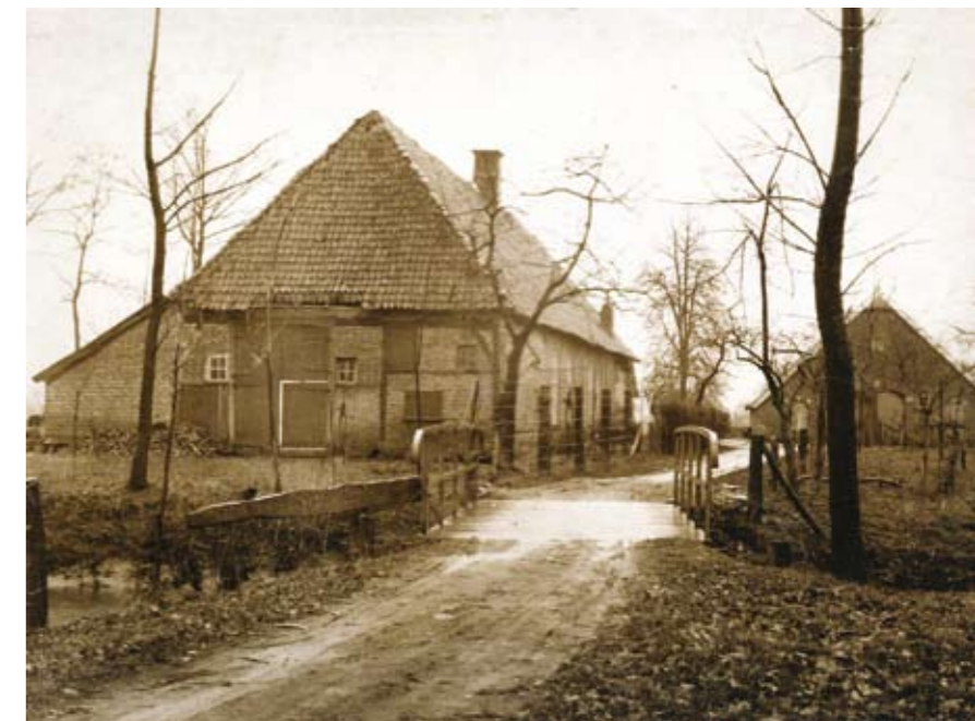
Plaatje 60. Tot 1744 heeft Gerrit ten Cate een grutterij op De Bongerd. Hij verhuist in dat jaar naar de Potkamp bij de Oude Kerk, midden in Borne. Deze foto van de Bongerd is tweehonderd jaar later gemaakt. Het grote gebouw links heeft muren met zware houten balken, die de muren in kleine vakken verdelen. Dat heet vakwerkbouw. Vroeger waren alle boerderijen zo gebouwd. Het bruggetje gaat over de Bornse Beek. De gebouwen zijn afgebroken.
