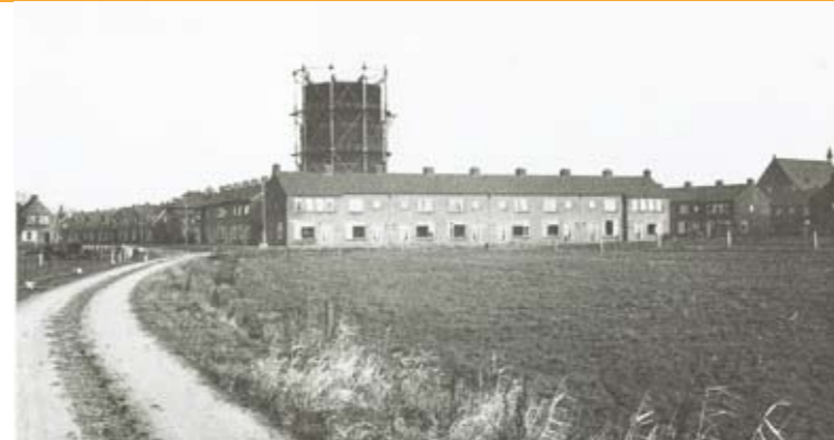
Plaatje 78. De foto is gemaakt rond 1960. Hoog boven de huizenrij aan de Welemanstraat rijst de geeentelijke gashouder op. Hij staat op de hoek van de Oude Hengelose weg (de zandweg) en de Theresiastraat. Vóór 1960 was er nog geen aardgas. Het gas voor Borne werd gemaakt in de Hengelose gasfabriek door steenkool te verhitten en werd door buizen naar deze gashouder gepompt. Hoe meer gas er in de gashouder was, hoe hoger hij werd.
