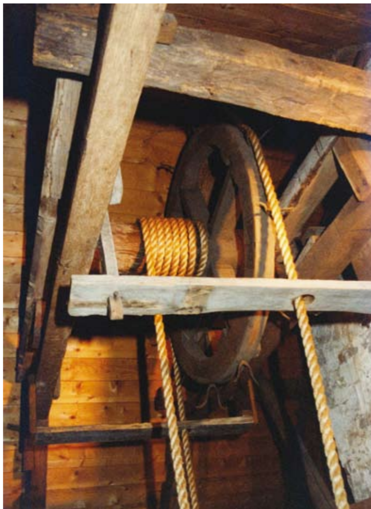
Plaatje 73. Deze takel in het Bussemakerhuis wordt 'luiwerk' genoemd.
